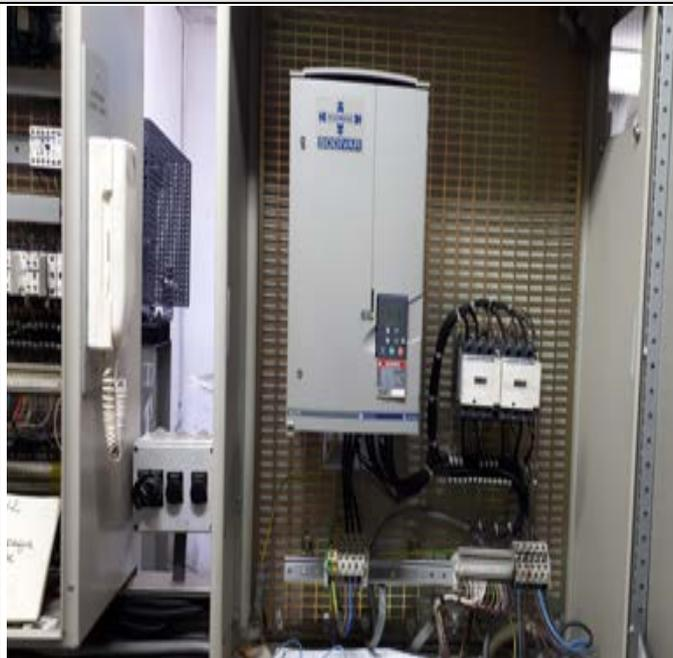
*Variateur de fréquence ascenseurs Impair et pair identiques aux deux appareils, remplacement préconisé*
