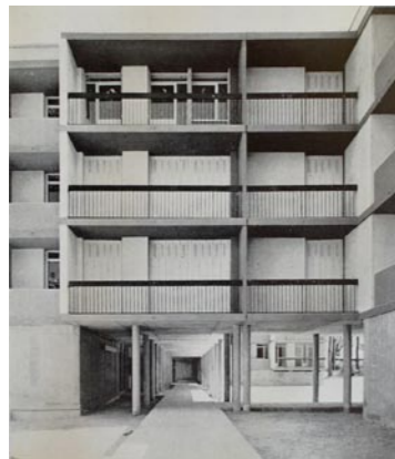
Vue sur les patios et pilotis – 1° tranche.
