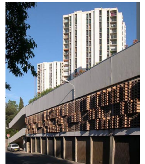
Vue sur le projet – 1° et 3° tranches.
